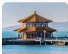
สะพานเจียงเฉียว
